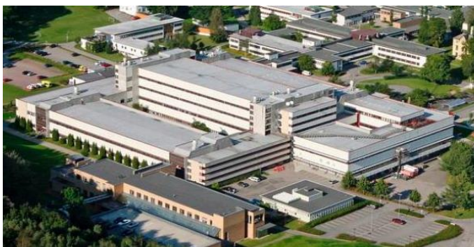
Bilde 1: Sørlandet sykehus Kristiansand, deler av hovedanlegget på Eg
